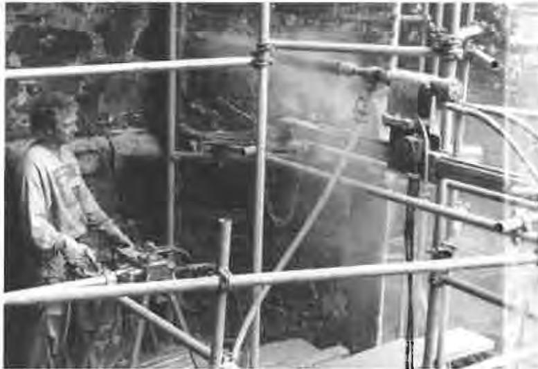
Längsbohrungen im Mauerwerk für das „Vorspannverfahren“ mit stählernen Ankern. Foto: Martin Zinz
