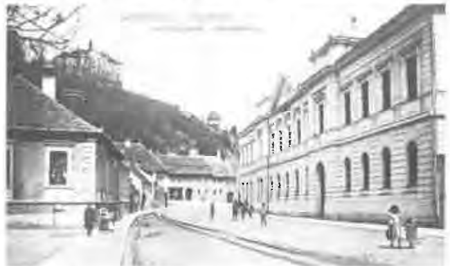
Michael-Eisenburger-Straße mit neuem Bezirksgerichtsgebäude. Archivbild
