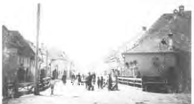
Brücke über den Hundsbach in der Baiergasse vor dem Abriss. Archivbild
