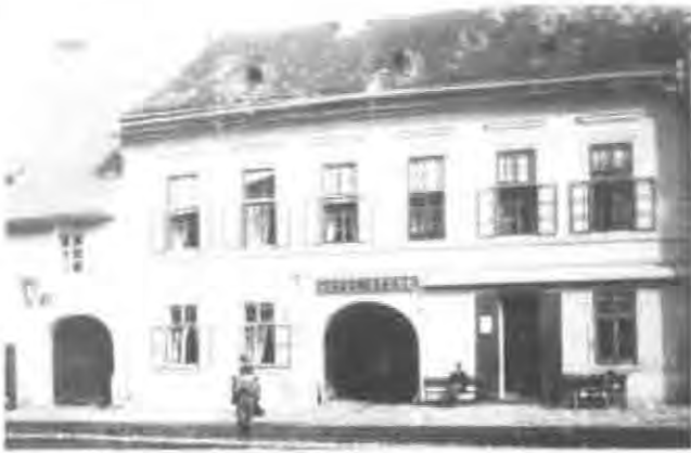
Hotel Stern in der Baiergasse vor dem Umbau 1910. Archivbild
