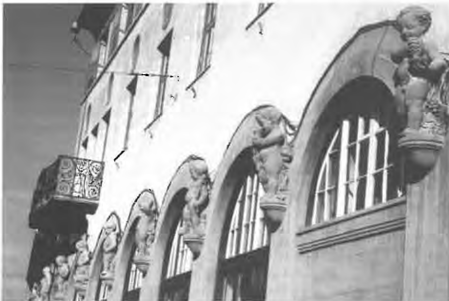
Detail Fassade des Hotels „Zum goldenen Stern“
