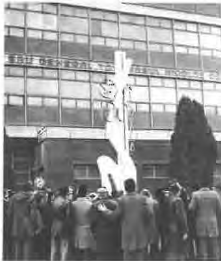
Vor dem Verwaltungsgebäude auf der Weißkircher Straße, 1982, die 100-Jahrfeier der Firma (West-Nicovala).
