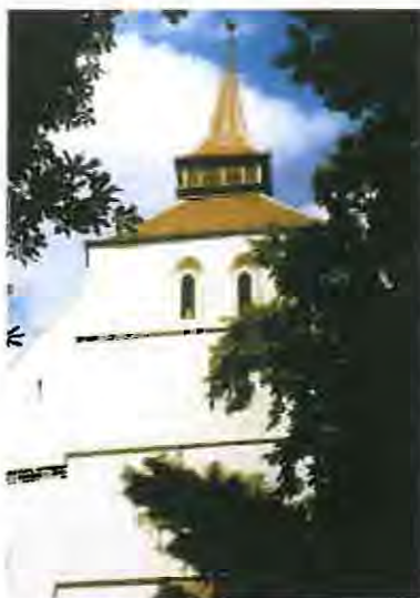
Bergkirche nach der Renovierung 1999.
