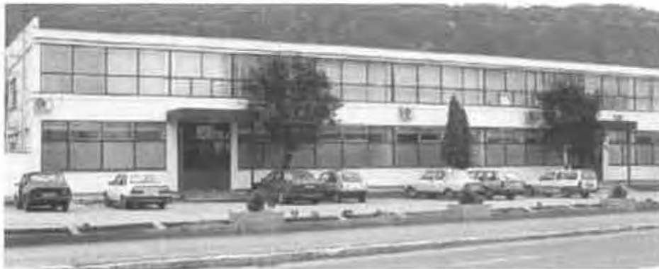
Die Firma Parat – Verwaltungsgebäude mit anschließender Werkshalle. Foto: Harald Gitschner
