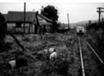
Zwei Jahre später sieht der Bahnhof verwahrlost aus. Seit einem Jahr ist kein regulärer Zug mehr gefahren. Nur die Draisine des Bahnhofspersonals Kornetzkel bereiste – wie auf unserem Bild zu sehen – regelmäßig die Strecke. Foto: Andreas Mausolf
