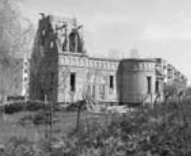
Kirche im Bau an der Weißkircher Straße
