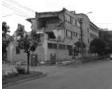
Abbruch der Wollweberei im Seilergang, alle Fotos dieser Reihe: Wilhelm Fabini
