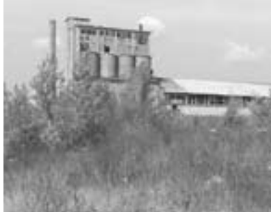
Weißkircher Straße (M. Viteazul), Ruine der Glasfabrik
