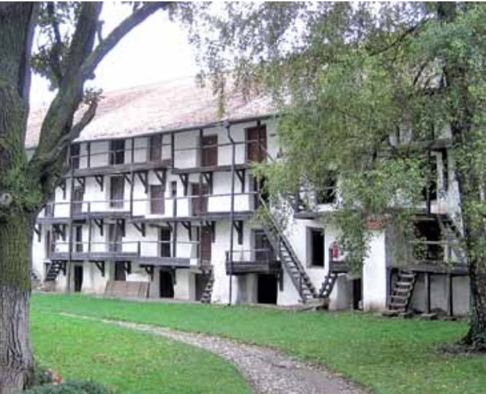
Notwohnungen in der Kirchenburg Tartlau
