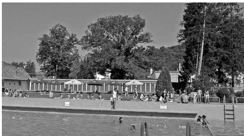
Die renovierte Schwimmschule heute, Fotos: Yvonne Baier-Varvara
