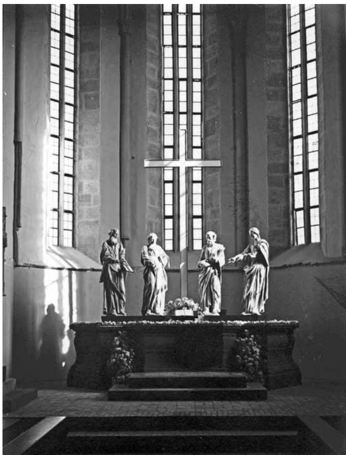
02 Blick in den umgestalteten Altarraum, 1934
