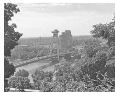
Schrägseilbrücke mit UFO / Bratislava
